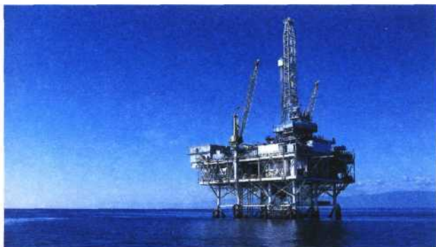
Буровая установка для добычи нефти на шельфе
